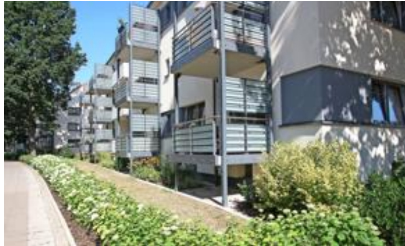
Nachgerüstet: Anbaubalkone stehen auf Stützen vor dem Haus. Sie können an vielen Bestandsbauten einfach errichtet werden.
