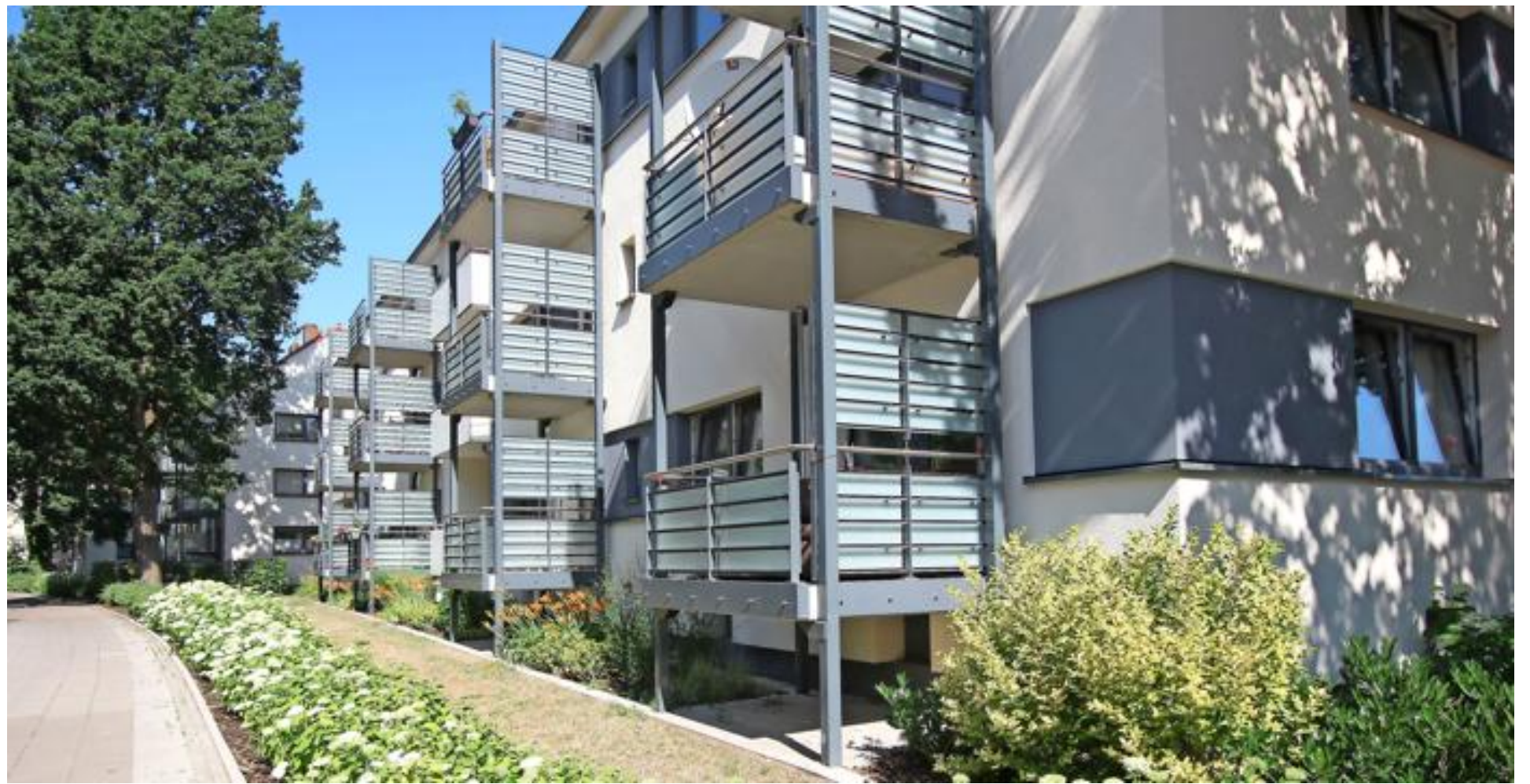
Nachgerüstet: Anbaubalkone, wie auf dem Bild zu sehen, stehen auf Stützen vor dem Haus. Sie können an vielen Bestandsbauten einfach errichtet werden.
